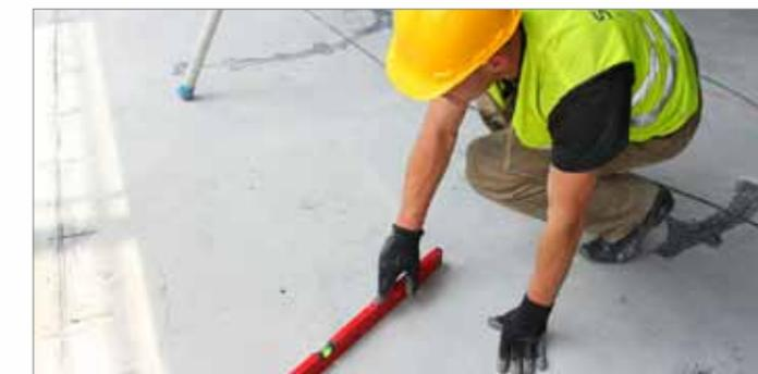
Фото 2. Измерение плоскости – допустимая погрешность составляет +/- 3 мм на длине 3 м.
