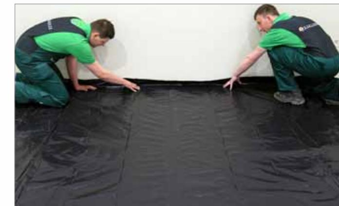
Фото 4. Гидроизоляция – важно, чтобы между стеной и полом оставить достаточный запас пленки.
